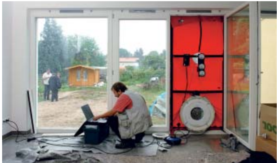
Die Stunde der Wahrheit: Beim Blower-Door-Test zeigt sich, ob das Gebäude wirklich luftdicht ist.
